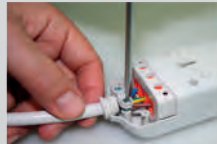
2- Connect the terminals / Fixer à la bride
