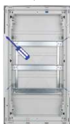
2- Fijar la caja al zócalo, mediante tornillos
