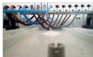
Amplio espacio para cableado: 45mm
